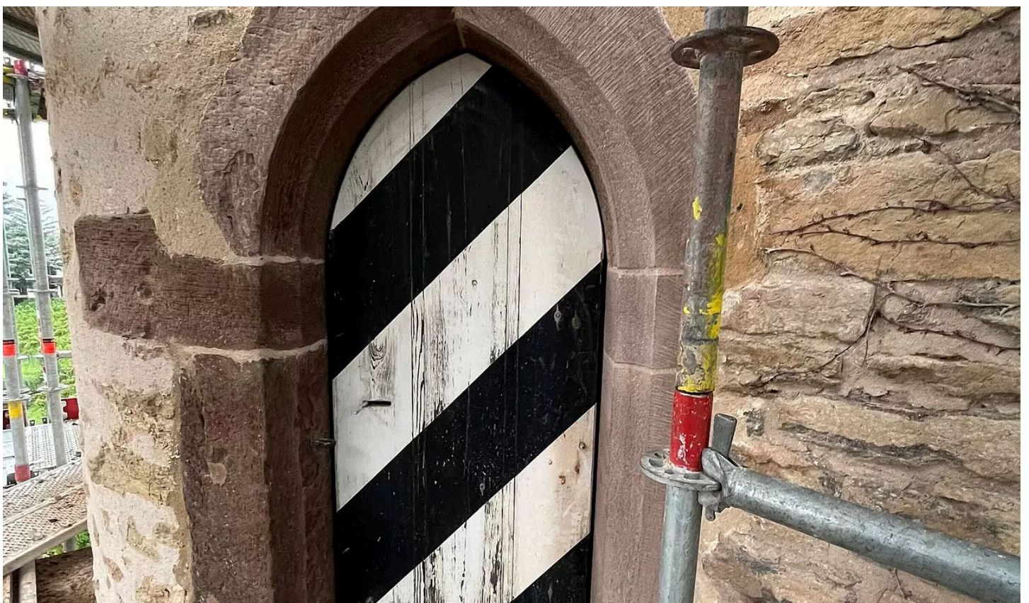
Die rechte Hälfte des Türbogens wurde durch neuen Sandstein ersetzt. Foto: Claudia Kostner
